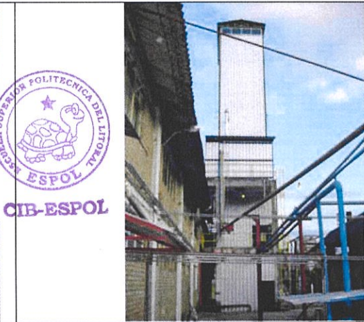
Edificio de torres de destilería
