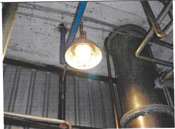
Iluminación a prueba de explosiones
