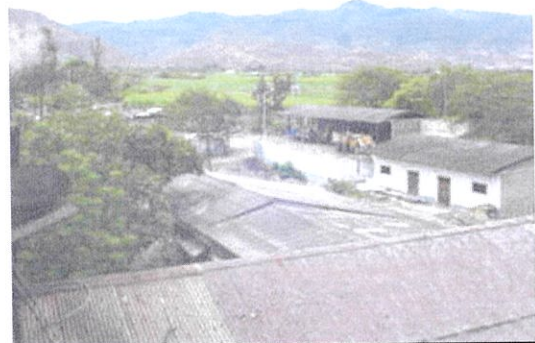
Vista superior de ingenio y talleres
