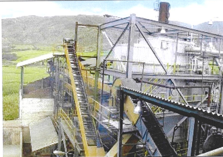
Caldera principal de ingenio.
