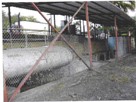
Depósitos de combustibles
