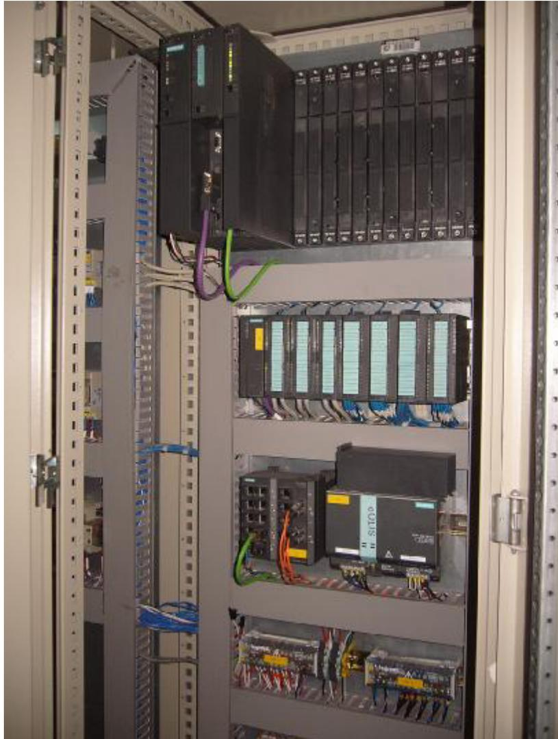
**Figura 5.6.- Panel de PLC energizado.**
