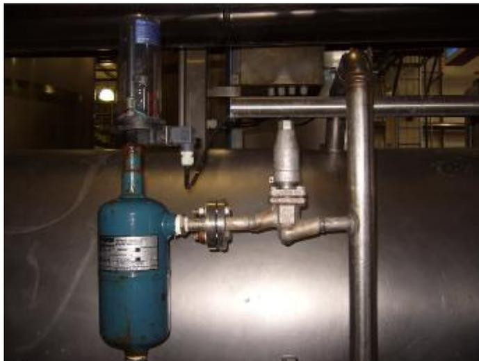
**Figura 5.30.- Instrumentación (Boya de nivel de Amoniaco) calibrada y operativa.**
