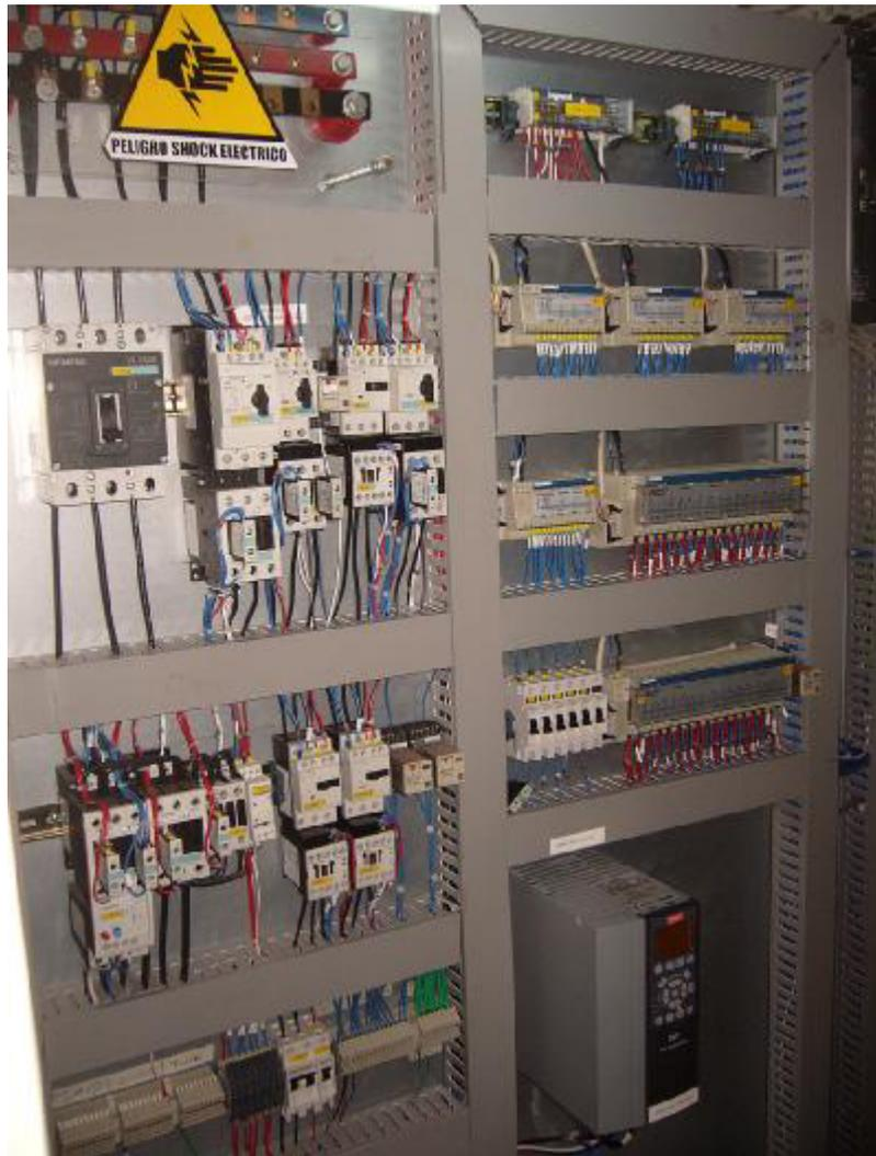
**Figura 5.5.- Equipos panel arrancadores # 2 energizados.**
