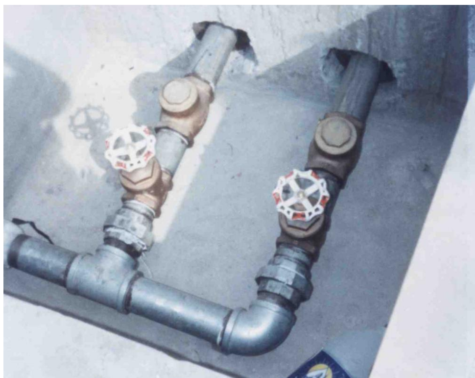
FIGURA 2.3 INSTALACIÓN DE VÁLVULAS DE COMPUERTA Y CHEQUE
