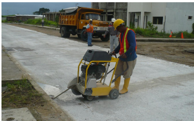
Figura 33.- Aserrado de juntas transversales – Vía V6
