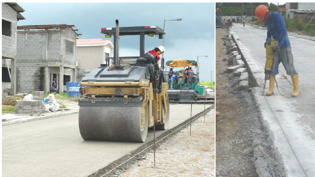
Figura 31.- Procedimiento de compactación y remoción de bordes libres
