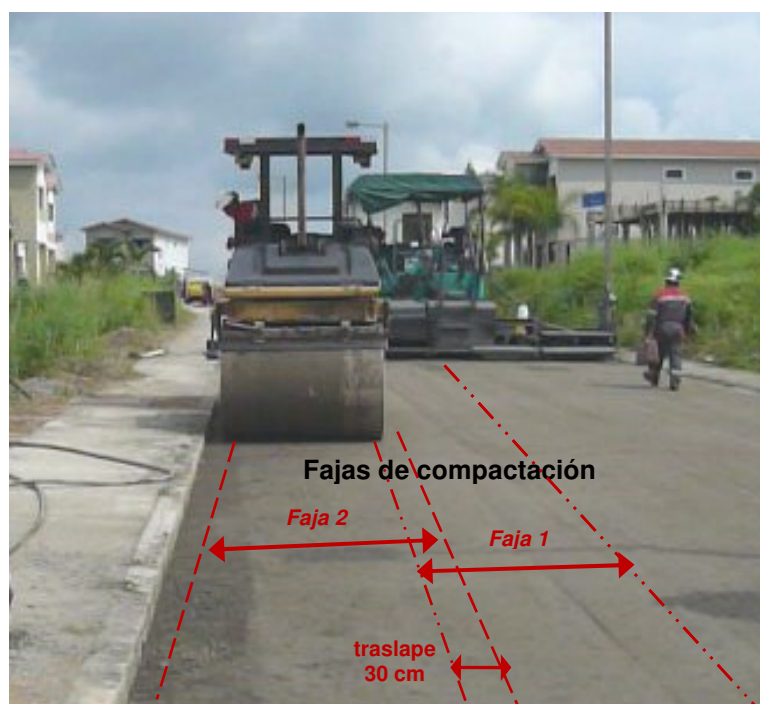
Figura 30.- Compactación en Vía V6'
