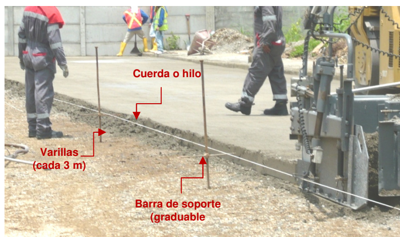
Figura 23.- Esquema de colocación de línea guía
