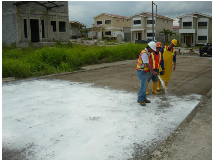
Figura 32.- Curado de losa de pavimento – Vía V6´
