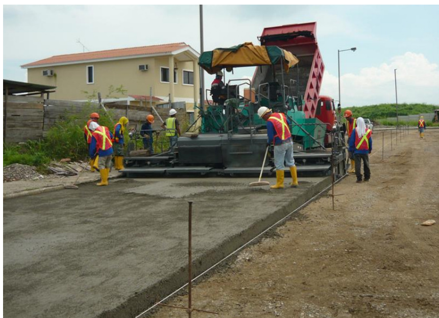
Figura 29.- Colocación del HCP
