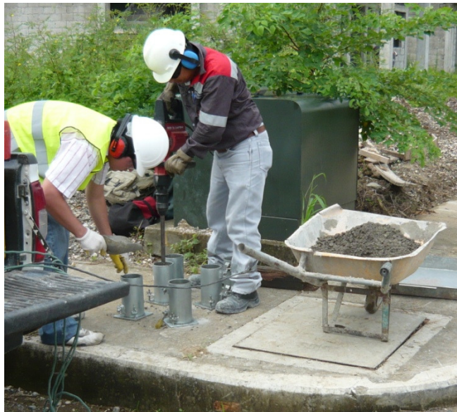
Figura 36.- Toma de muestras del hormigón fresco
