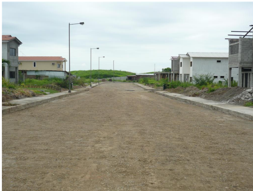
Figura 22.- Capa de sub-base preparada (Avenida Iglesia-V6)
