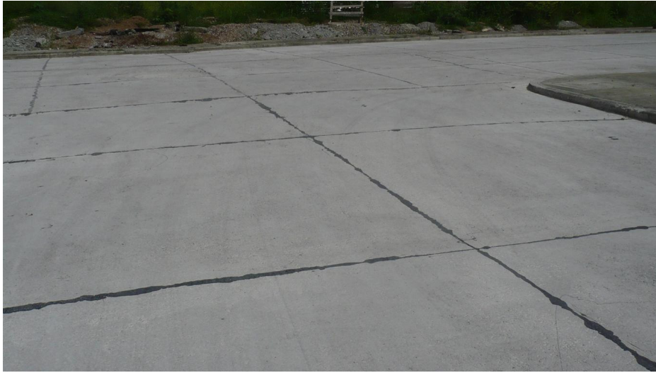
Figura 34.- Juntas rellenas con AP-3. Intersección Avenidas V6 y V6'
