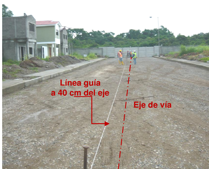
Figura 25.- Colocación de Línea guía en eje de Vía V6
