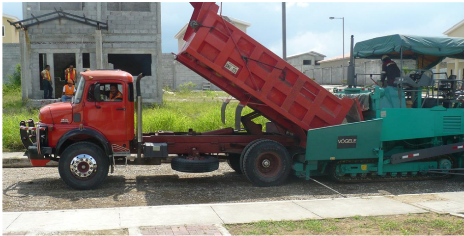
Figura 26.- Descarga del Hormigón
