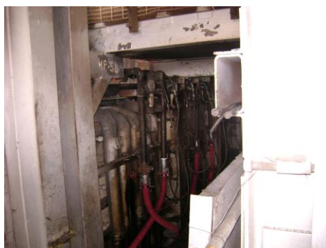
Fig. 3.13 Área de Quemadores (después)
