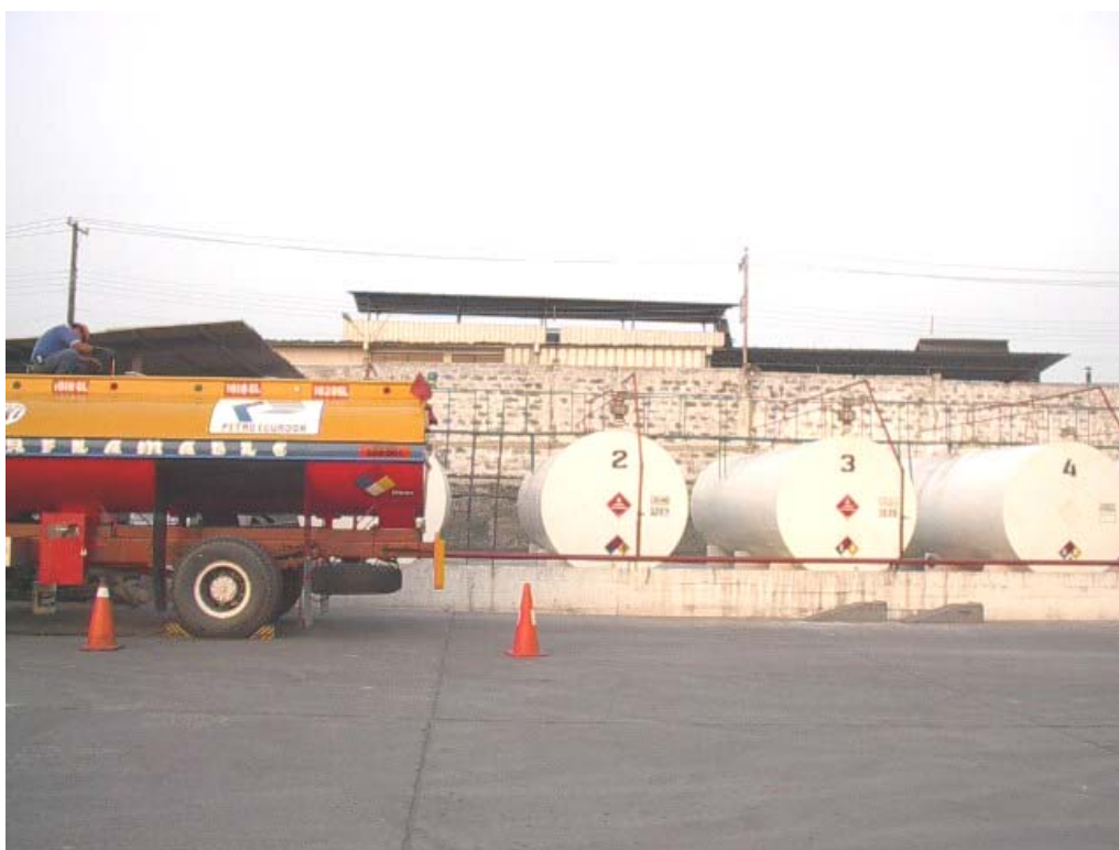
FIGURA 3-1. VISTA GENERAL DE LOS TANQUES A INSPECCIONAR
