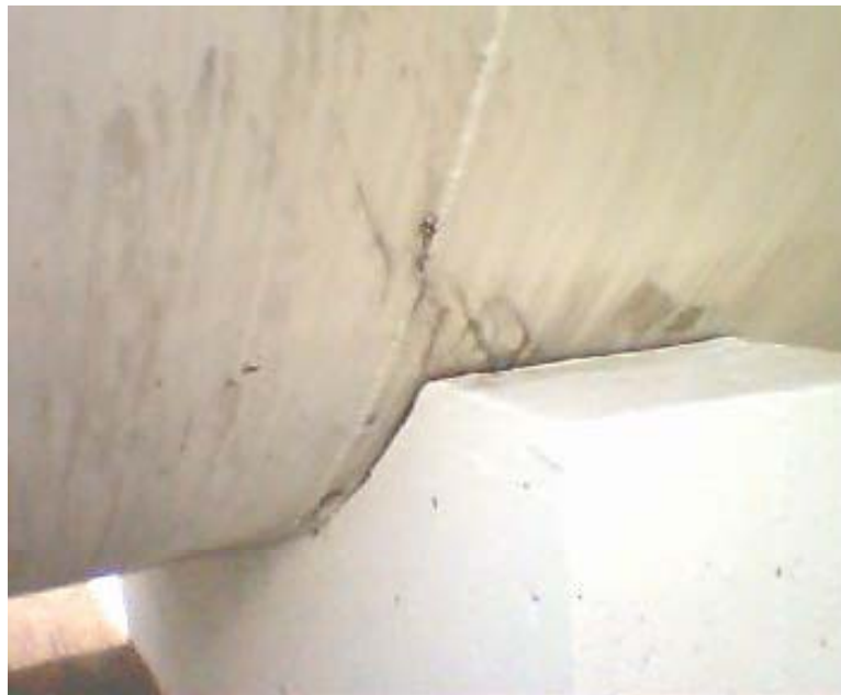
FIGURA 3-4. CORROSIÓN EN LAS SILLETAS DE SOPORTE- TK 2
