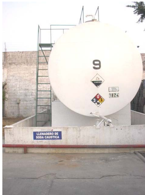
FIGURA 3-8. DISTANCIA DE TANQUE A CUBETO INADECUADO– TK 9
