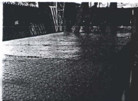
FIGURA 3.17 CUBIERTA EN PLANCHA ANTIDESLIZANTE
