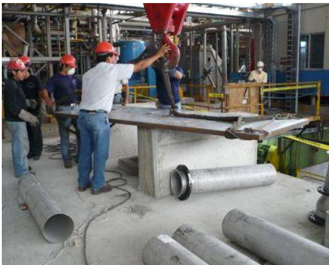
FIGURA 2.5 INSTALACIÓN DE PLACAS BASE
