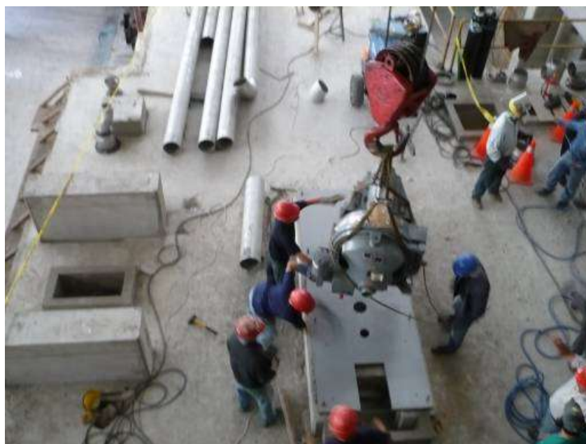
FIGURA 2.6 MONTAJE DE REFINADOR 20" DD
