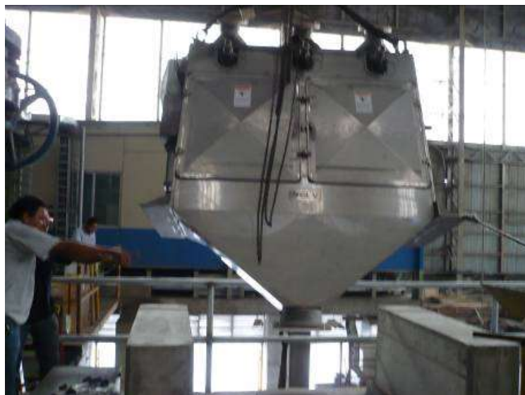
FIGURA 2.8 MONTAJE DE ESPESADOR DE FIBRA.
