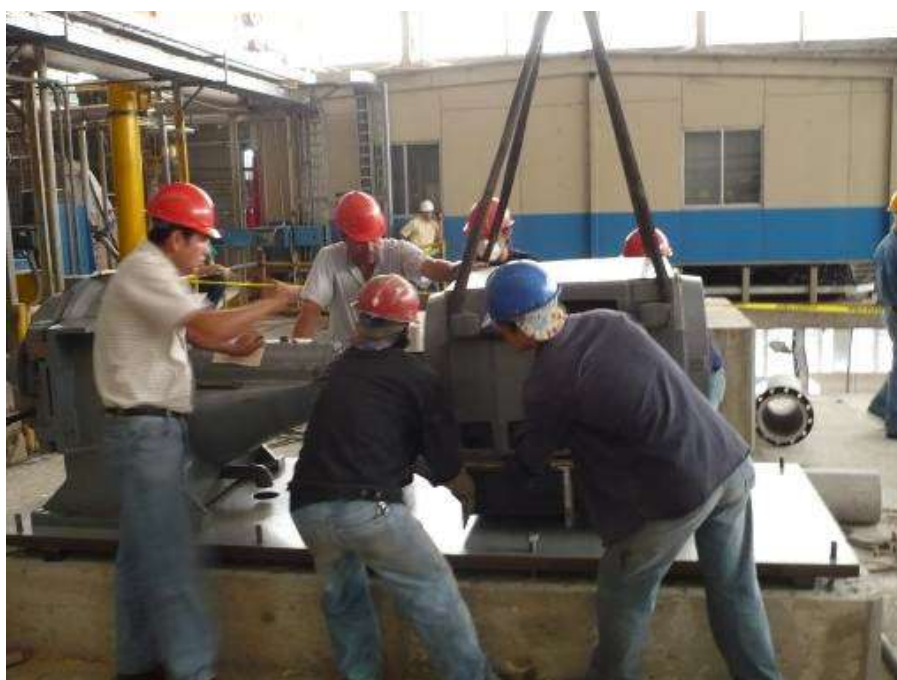
FIGURA 2.7 MONTAJE DEL MOTOR.
