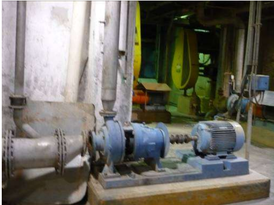
FIGURA 2.12 ACONDICIONAMIENTO DE BOMBA DE FIBRA CORTA.
