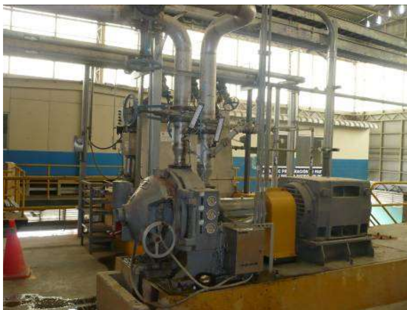
FIGURA 2.9 REFINADOR DE FIBRA CORTA (INSTALACIÓN FINAL)
