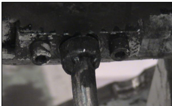
FIGURA 5.8: ALINEADOR DE BOBINA CON DEFECTO (PIEZA SOLDADA)(ANTES).
