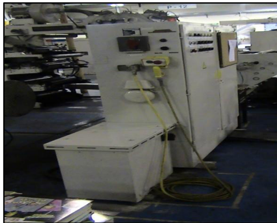
FIGURA 4.11: CONSTRUCCIÓN DE MESA DE MADERA COMO PARTE DE LAS MEJORAS DE LA LÍNEA
