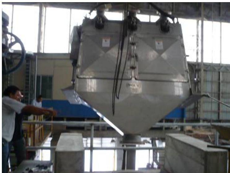
FIGURA 2.8 MONTAJE DE ESPESADOR DE FIBRA.
