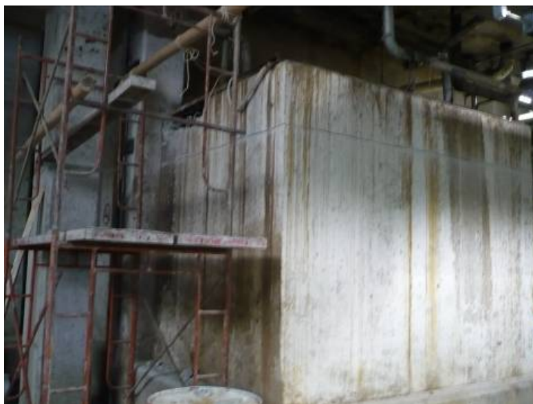
FIGURA 2.11 ACONDICIONAMIENTO DE TANQUE DE ALMACENAMIENTO DE FIBRA CORTA.
