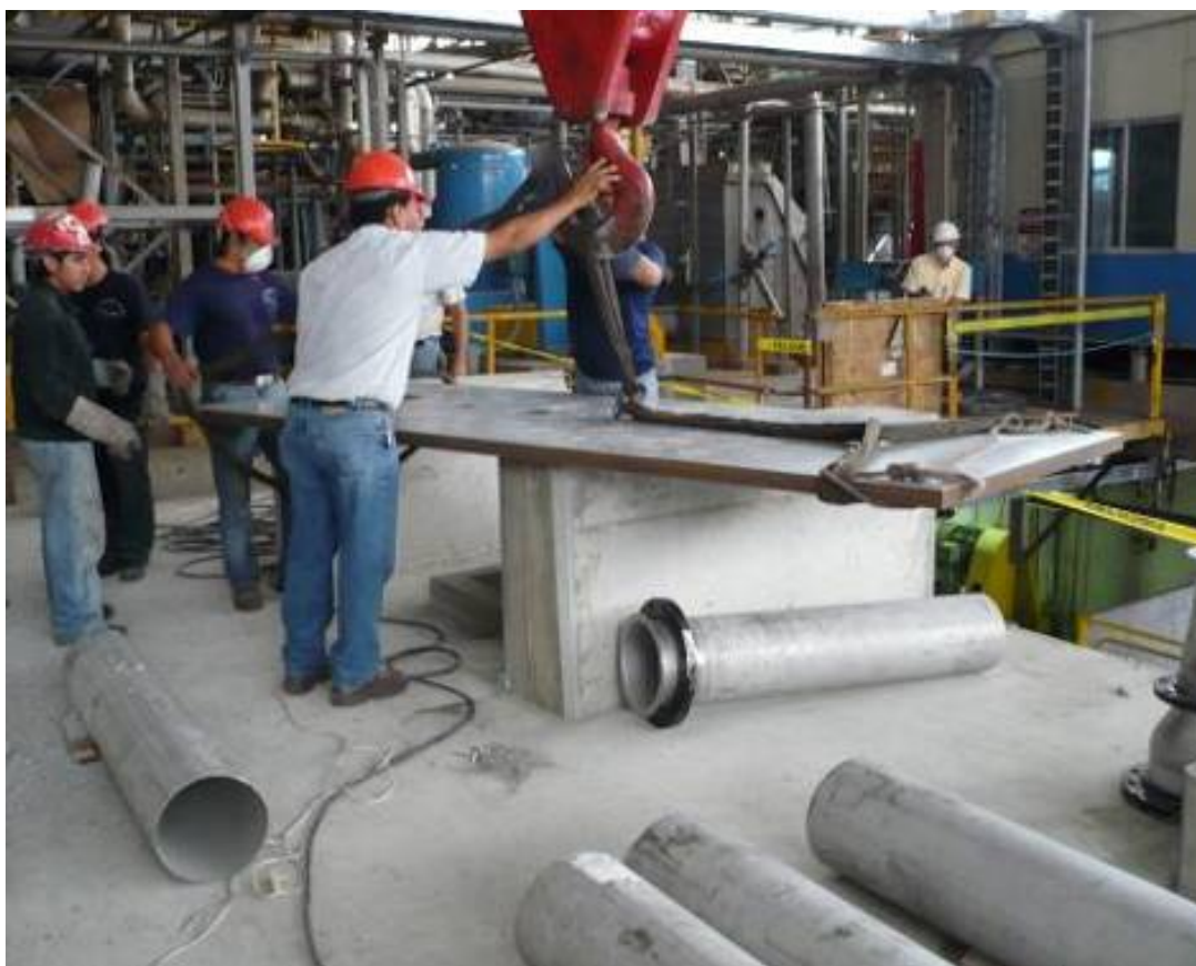
FIGURA 2.5 INSTALACIÓN DE PLACAS BASE
