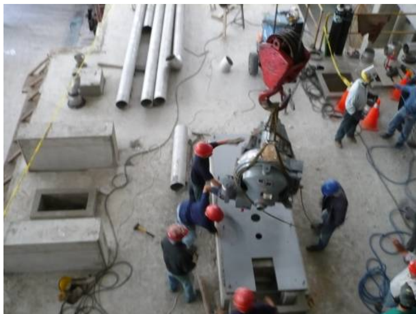
FIGURA 2.6 MONTAJE DE REFINADOR 20" DD
