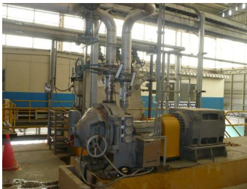
FIGURA 2.9 REFINADOR DE FIBRA CORTA (INSTALACIÓN FINAL)
