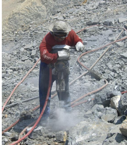
Figura 5.1.- Martillo Trabajando, Cantera Borcons
