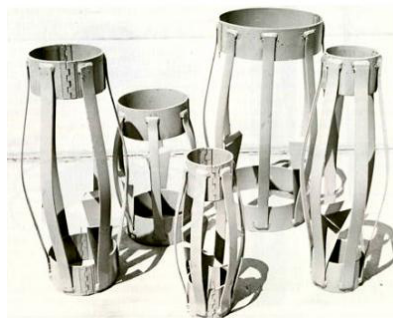
FIGURA 4.1 CENTRALIZADORES
