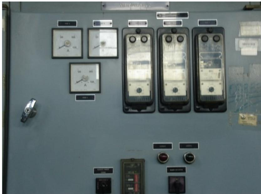
Figura 1.4. Protecciones de los Motores trifásicos de 1250
