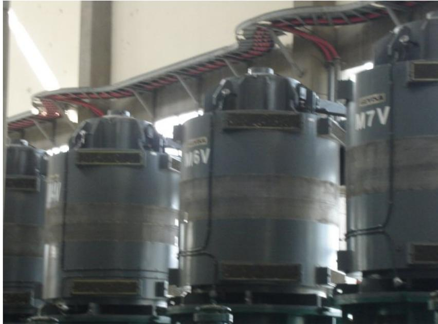
Figura 1.1. Motores trifásicos de 3000HP, 13800V
