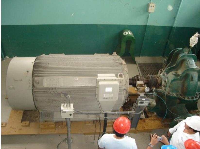
Figura 1.3. Motores trifásicos de 1250 HP, 4160 V, 125 A
