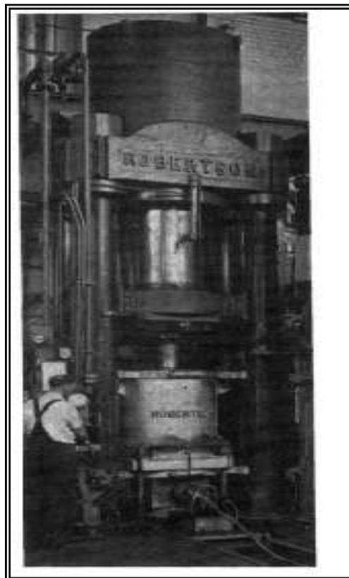
FIGURA 1.2. TÍPICA PRENSA DE EXTRUSIÓN VERTICAL
