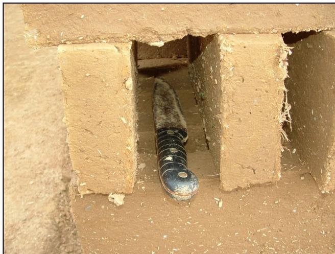
**FIGURA 3.9. Rebabado de ladrillos con cuchillas**
