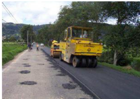
Figura 34. Renivelación con sobrecarpeta con mezcla asfáltica en frío
