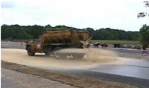
Figura 30. Sello de arena asfalto
