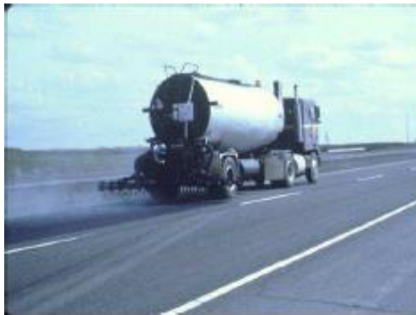
Figura 26. Aplicación de riego en negro de un carril
