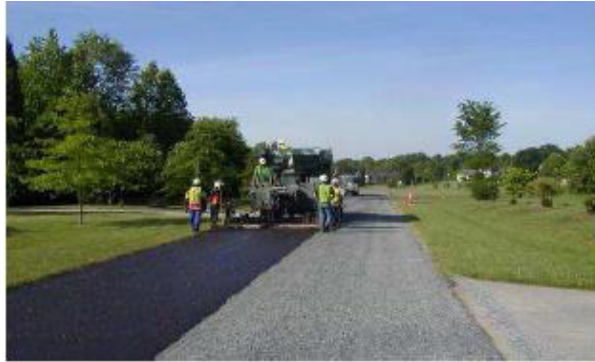
Figura 33. Renivelación con sobrecarpeta con mezcla asfáltica en caliente
