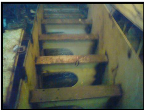
Figura N°14. Montaje de bases de motores principales.
