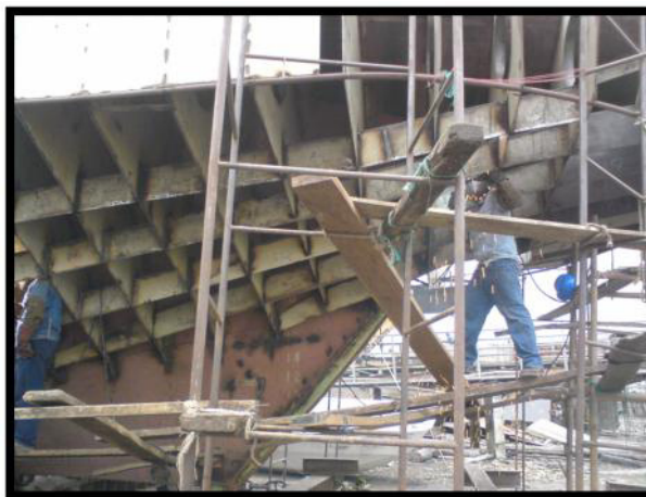
Figura N° 6. Soldadura del ala de longitudinales de fondo.
