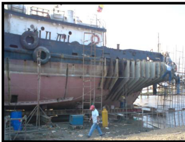
Figura N° 4. Montaje de nuevas cuadernas y mamparos.
