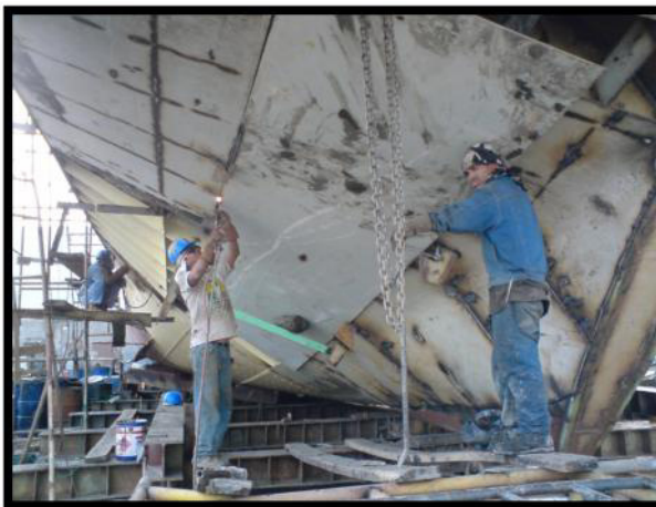
Figura N° 8. Montaje del fondo del casco.
