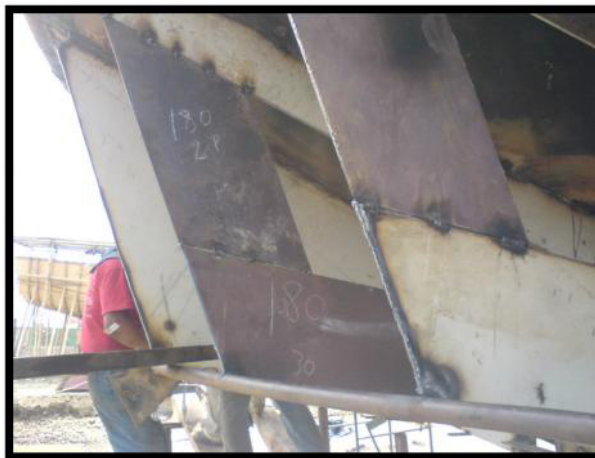
Figura N° 5. Armado de longitudinales de fondo.
