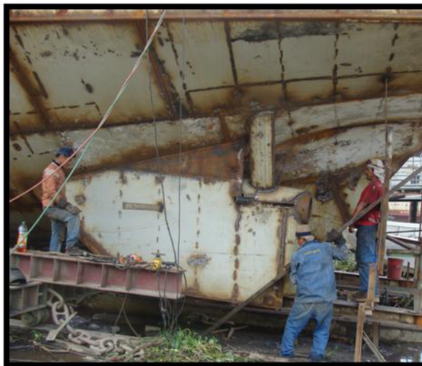
Figura N° 16. Montaje de codaste de Babor.
