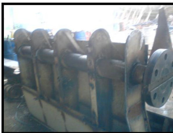
Figura N°12. Construcción de palas del timón.
