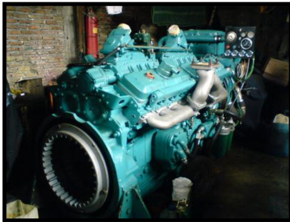
Figura N° 33. Nuevo motor principal instalado.
