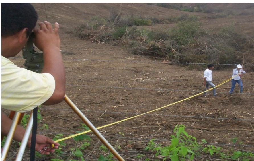
FIGURA 3.3: REPLANTEO DE LA LÍNEA TERCIARIA.
