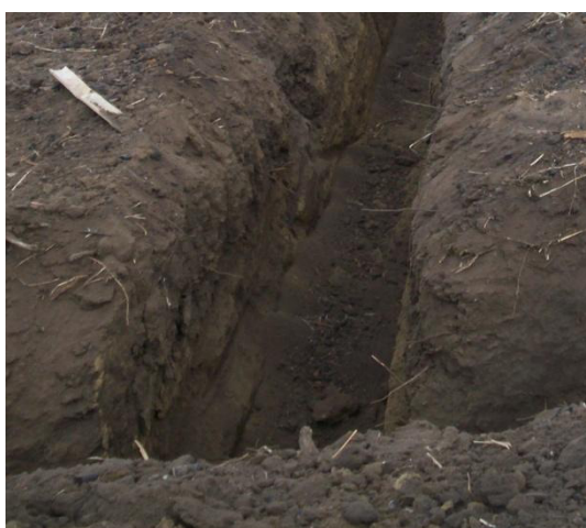
FIGURA 3.8: ZANJA PARA TUBERÍA PRINCIPAL
