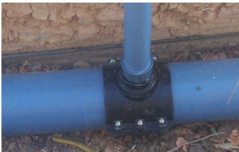
FIGURA 3.13: INSTALACIÓN DE COLLARIN.
