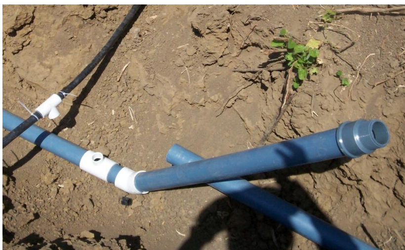
FIGURA 3.12: ACOPLE DE TUBERÍA SECUNDARIA A Terciaria.
