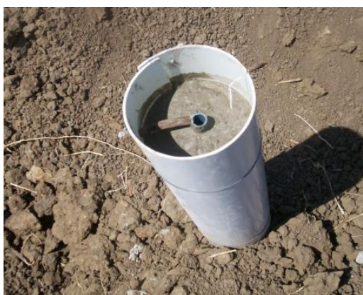
FIGURA 3.21: FUNDICIÓN DE ELEVADORES.
