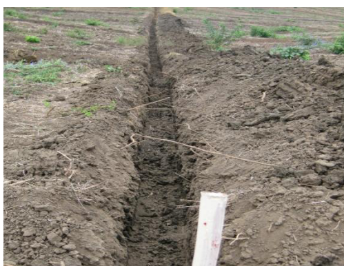
FIGURA 3.7: EXCAVACIÓN DE ZANJA SECUNDARIA.
