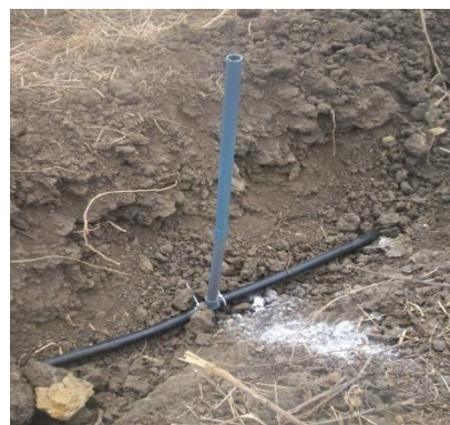
FIGURA 3.19: INSTALACIÓN DE ELEVADORES.
