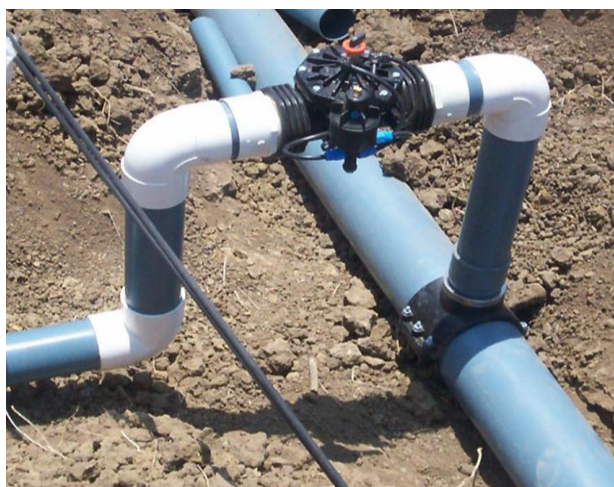
FIGURA 3.15: INSTALACIÓN DE LA VÁLVULA DE CONTROL.
