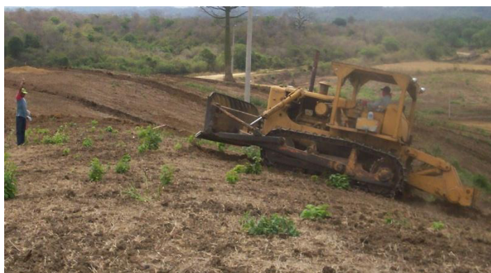
FIGURA 3.5: EXCAVACIÓN DE LA LÍNEA TERCIARIA.
