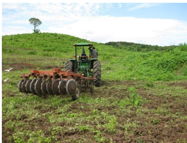
FIGURA 3.1: DESBROCE Y LIMPIEZA DEL TERRENO.
