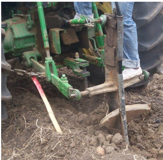
FIGURA 3.9: INSTALACION DE LA LÍNEA TERCIARIA.
