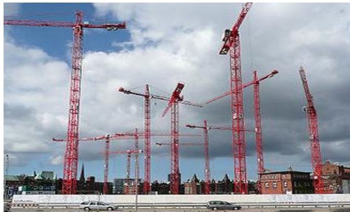
FIGURA 1. 7 GRÚAS DE TORRE
