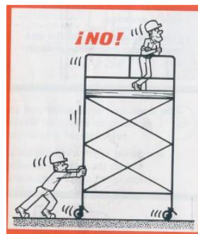
Fig.1. 10 Uso de barandas en andamios
