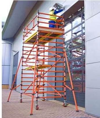
Fig.1. 9 Plataformas de andamios
