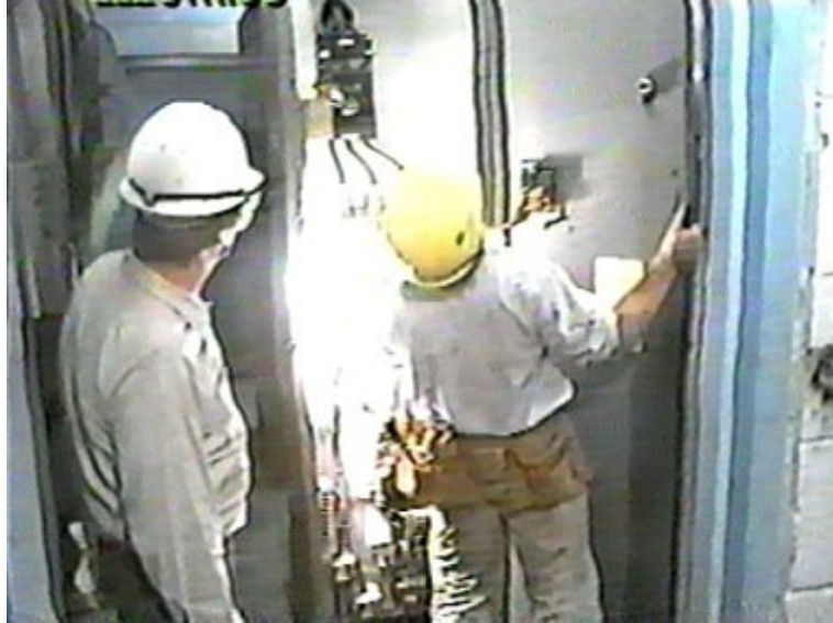
Figura 1.2: Personal trabajando en barras principales
