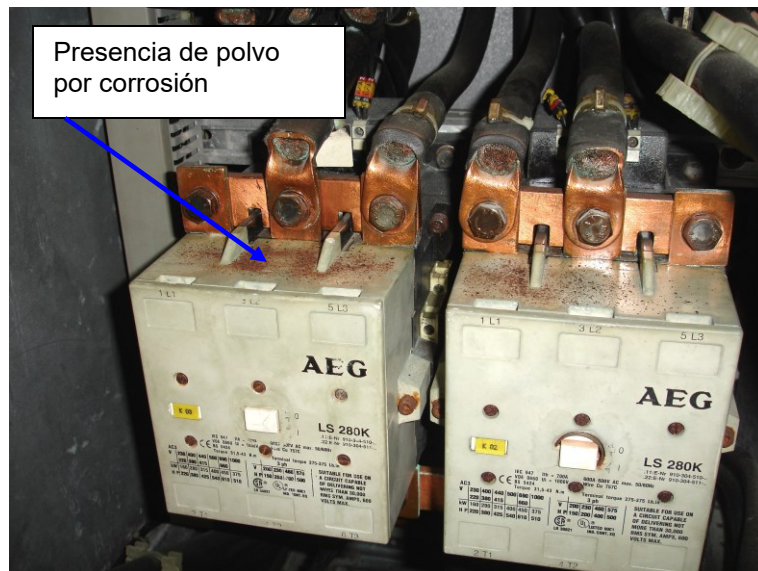
Figura 1.1: Sistema arrancador para un motor
