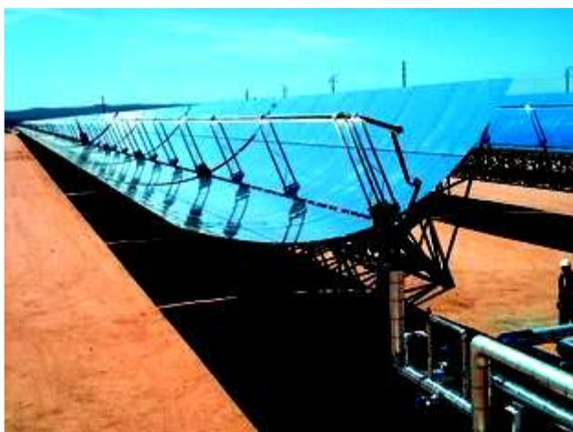
**Figura N° 3.7.** Colector cilindro parabólico
