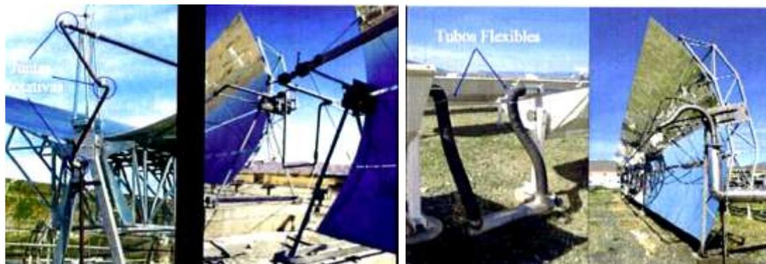
**Figura N° 3.14.** Juntas de conexión entre paneles.
