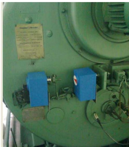
Actuador para damper de aire y combustible Honeywell modelo ML7999B
