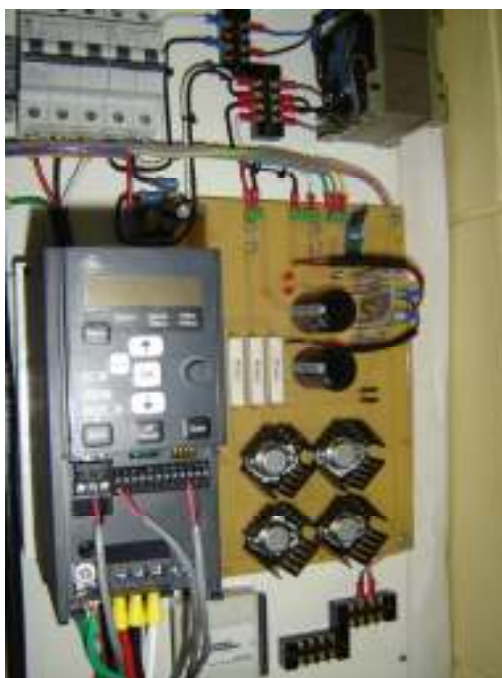
Figura 27. Montaje de Tarjetas
