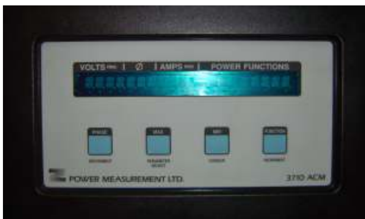
Figura 22. Medidor de Energía Power Measurement 3710.
