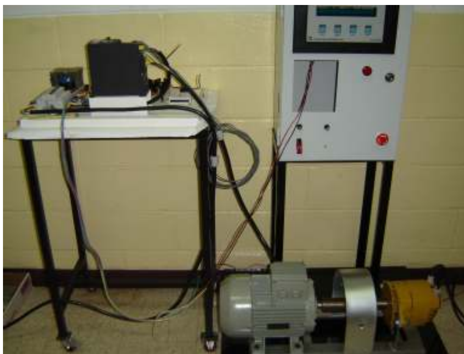
Figura 28. Proceso de cableado y prueba de equipos.
