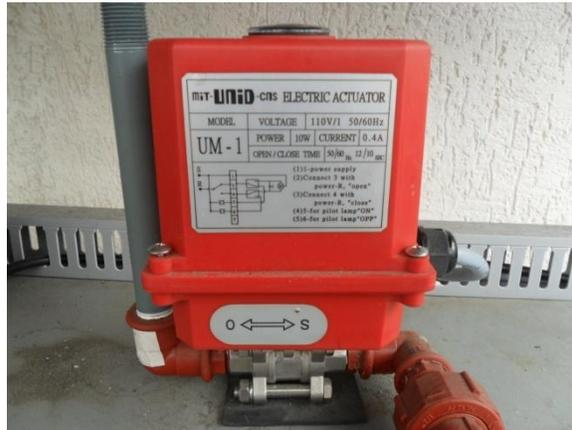
**Figura 22.- Actuador eléctrico para válvula.**
