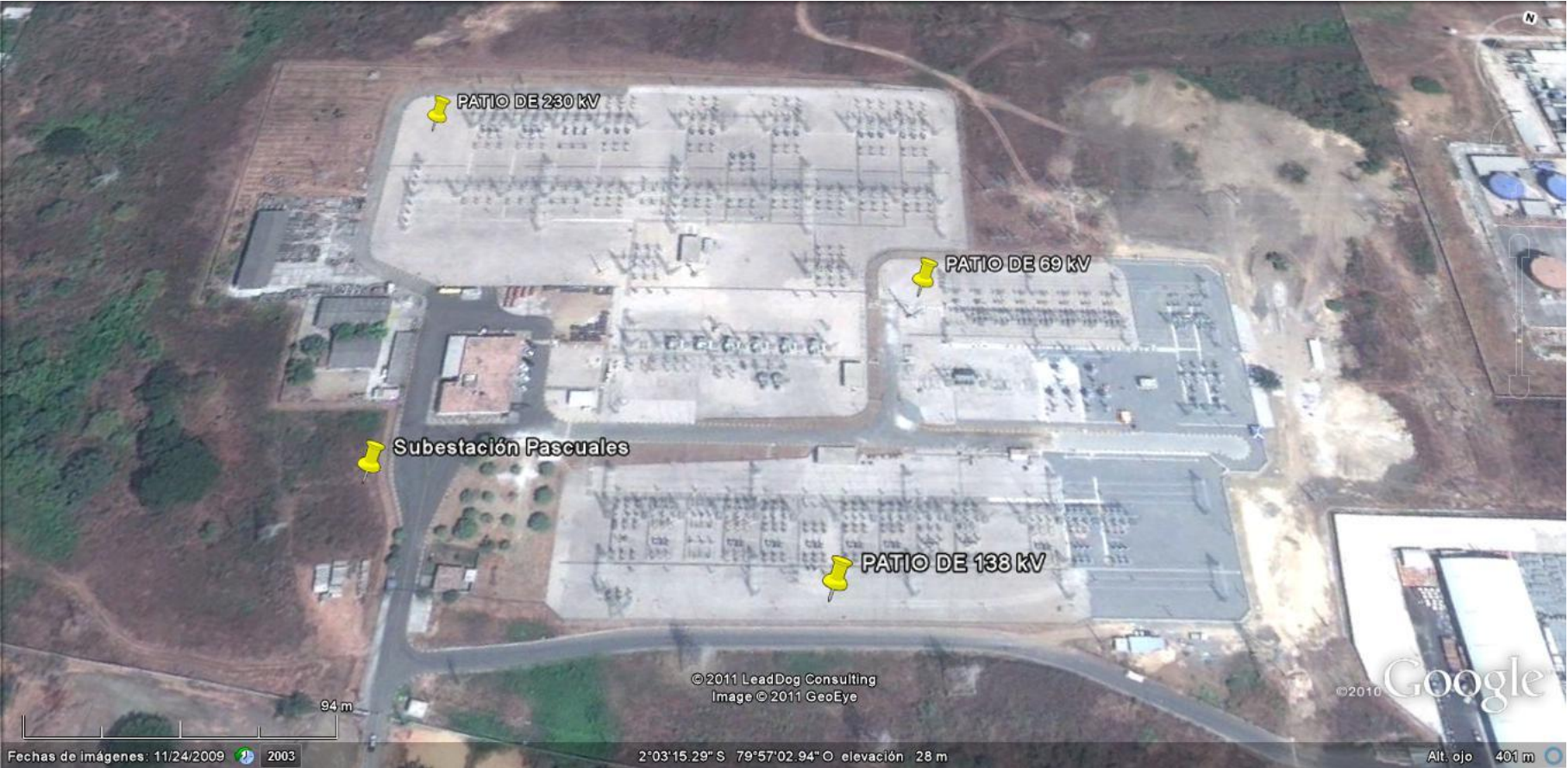
Figura C: Vista panorámica de la subestación Pascuales
