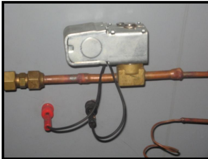
Figura 25 – Válvula solenoide
