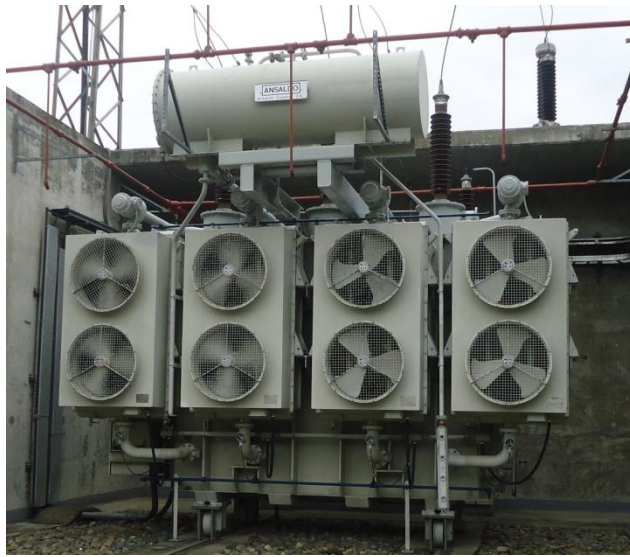
Figura 1.5 Transformador Principal.
