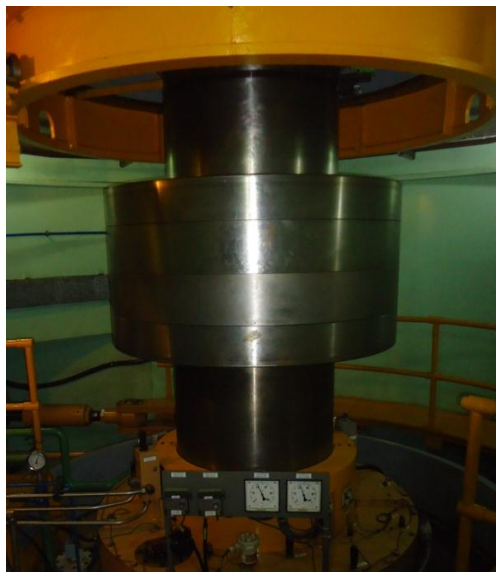
Figura 1.4 Acople Turbina-Generador.
