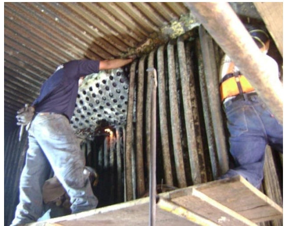
Reemplazo De Tubos En Mal Estado De Caldera
