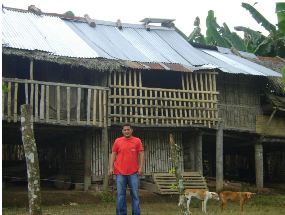
Figura 47.- Vivienda dotada de panel solar
