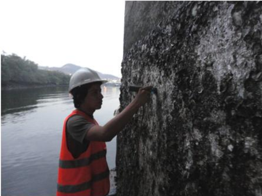
FIGURA 3.23: COLOCACIÓN DEL SENSOR B EN EL PUNTO DE MEDICIÓN
