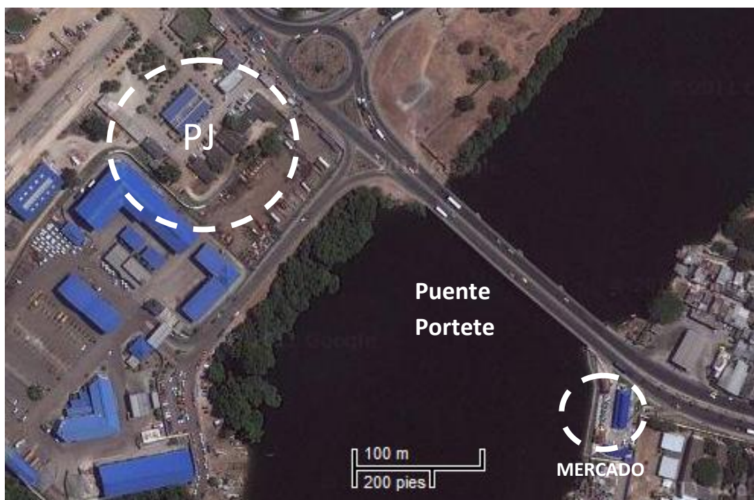
FIGURA 3.2: FOTO SUPERIOR DEL PUENTE
