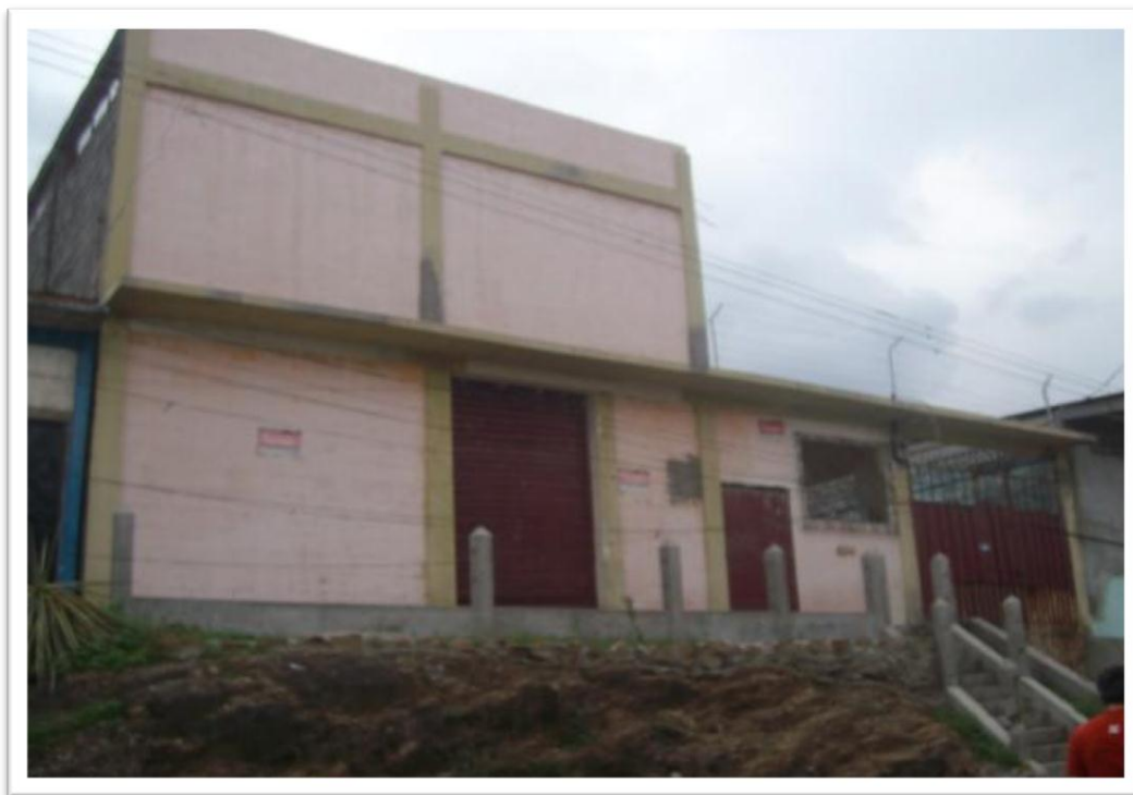
Figura 11. Parte exterior del local B
