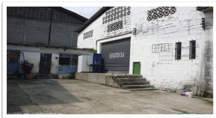
Figura 8. Parte exterior del local A
