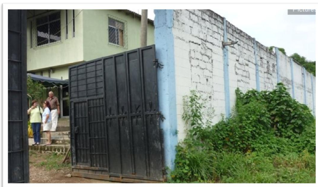
Figura 10. Parte exterior 2. del local A
