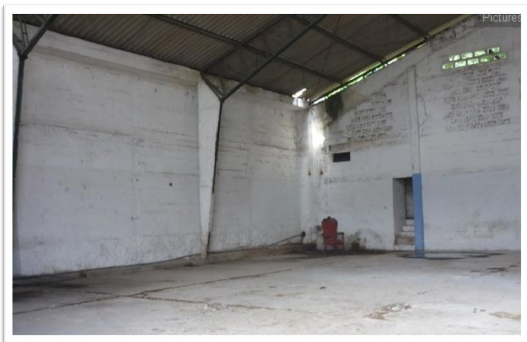
Figura 9. Parte interior del local A
