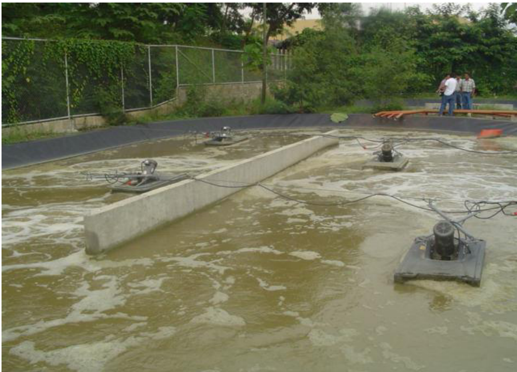
Digestor: confinamiento y reducción final de lodos.
