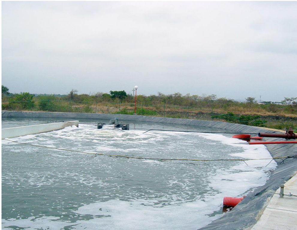
Laguna de Aireación: reactor biológico principal donde ocurre el tratamiento
