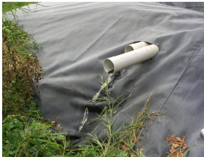
En esta imagen se observa el momento que las aguas residuales del Campus GG desembocan en el medio ambiente
