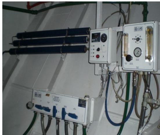
FIGURA 1.19 PLANTA DESALINIZADORA DE PROA A ESTRIBOR
