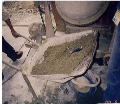
Ilustración 0.39 Dosificación y mezclado
