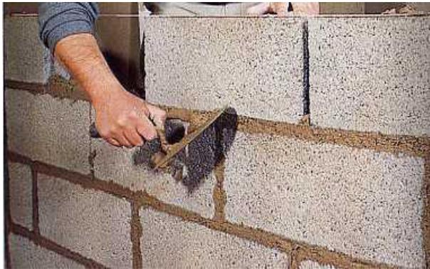
Ilustración 0.13 Colocación de bloques de hormigón
