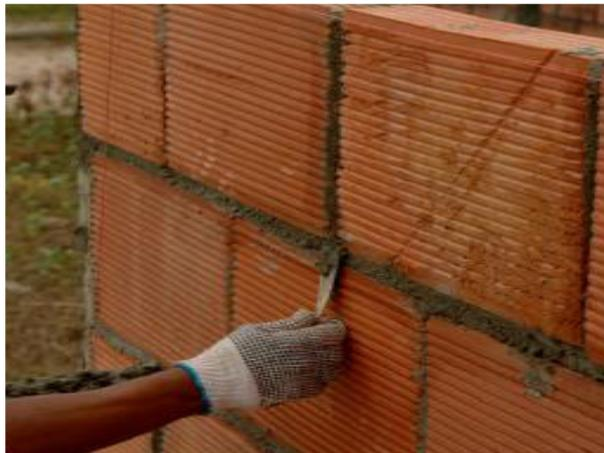
Ilustración 0.14 Colocación de bloques de arcilla
