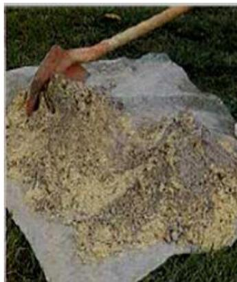
Ilustración 0.7 Mezcla en seco de cemento y arena
