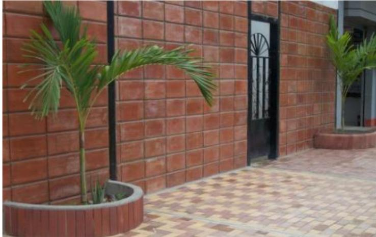
Ilustración 0.21 Usos de bloques de arcilla en paredes
