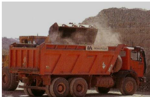
Ilustración 0.3 Extracción y traslado de arcilla
