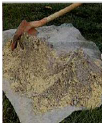
Ilustración 0.7 Mezcla en seco de cemento y arena
