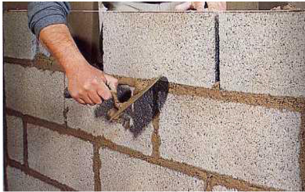
Ilustración 0.13 Colocación de bloques de hormigón
