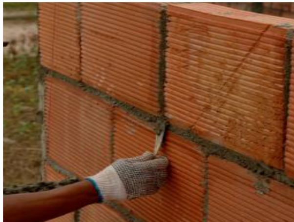
Ilustración 0.14 Colocación de bloques de arcilla
