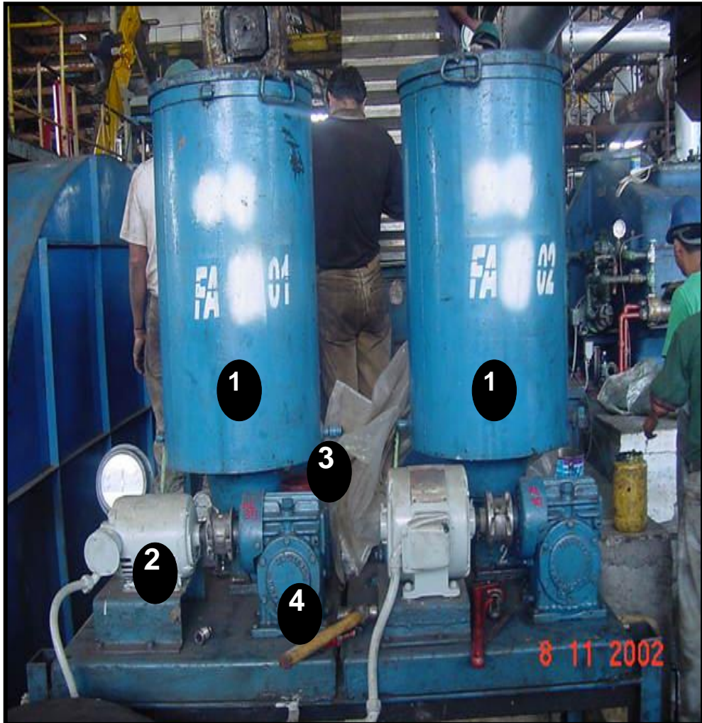
FIGURA 2.1 COMPONENTES PRINCIPALES DE UN SISTEMA FARVAL
