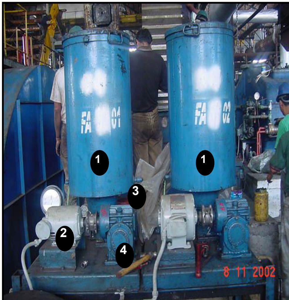
FIGURA 2.1 COMPONENTES PRINCIPALES DE UN SISTEMA FARVAL
