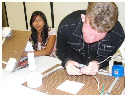
Figura 111. Instalación básica de focos con interruptor.
