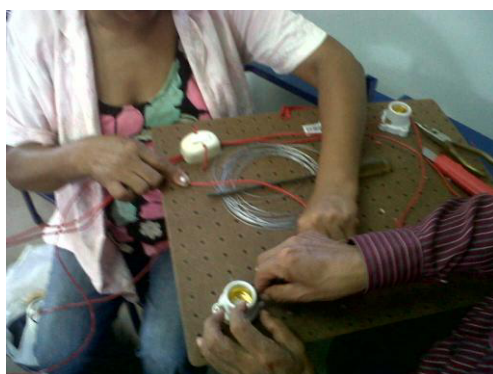
Figura 7. Instalación de boquillas.
