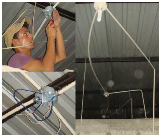
Figura 109. Instalación de tubo PVC y cables.
