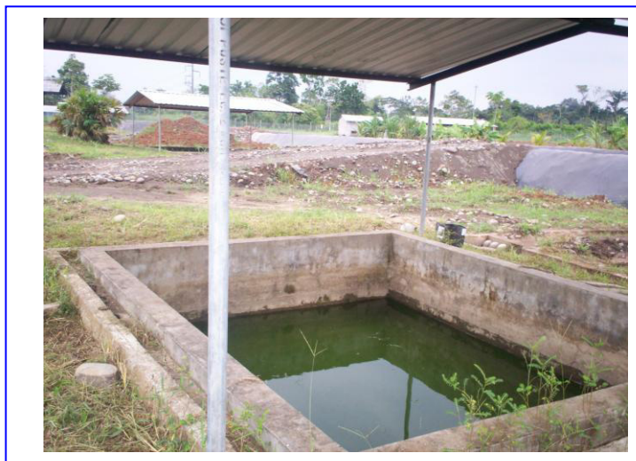
Fig.3.21 Piscina de cemento receptora de lixiviados provenientes de la Unidad de Landfarming.; tomada en el Cañón de los Monos-Coca, Cristina Ballesteros, febrero del 2007.
