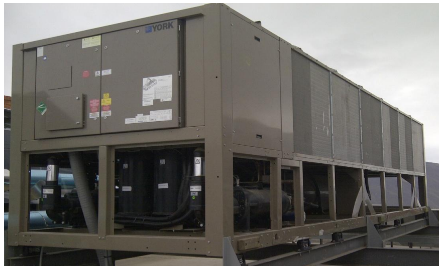
FIGURA 3.1 CHILLER ENFRIADO POR AIRE
