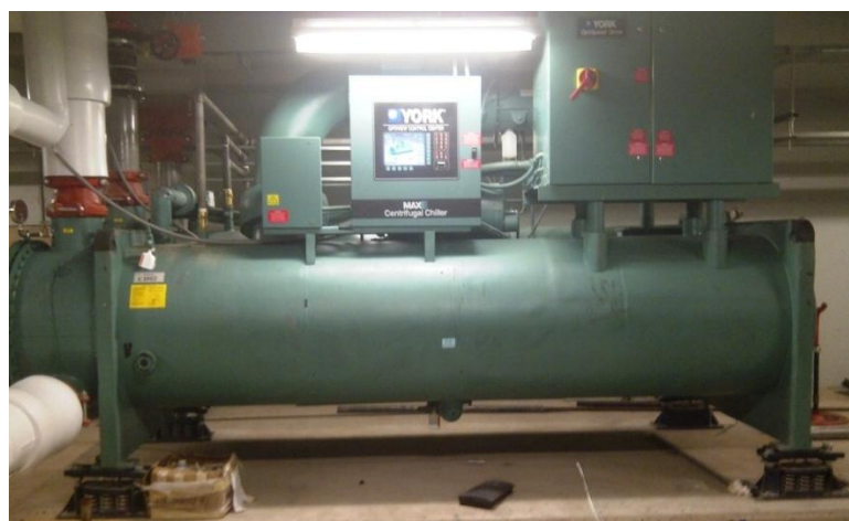
FIGURA 3.2 CHILLER ENFRIADO POR AGUA
