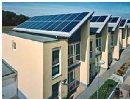
**Figura 31.-** Instalación solar integrada en tejadas de viviendas
