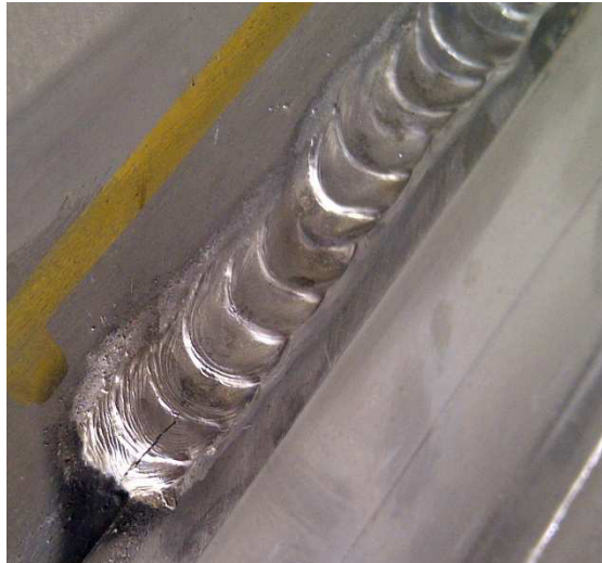
Figura 3.3.1 Fisura en Cordones de Soldadura
