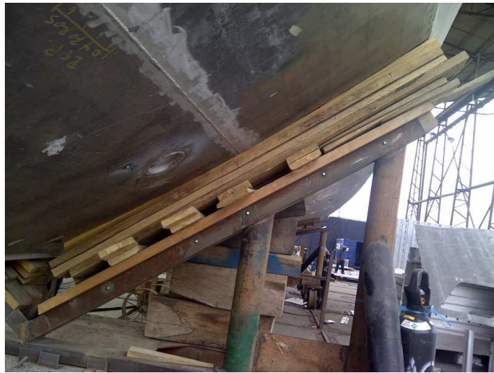
Figura 3.4.1 Acuñaamiento de embarcaciones de aluminio
