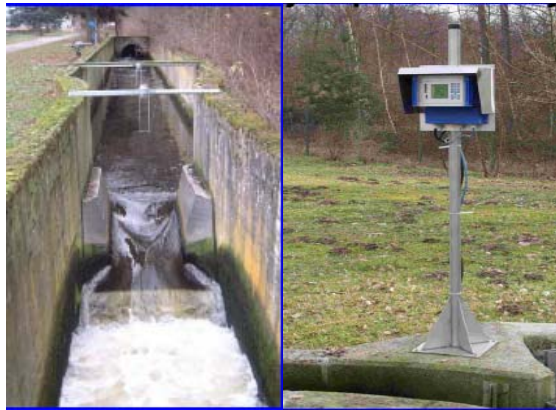
FIGURA 7. UNIDAD PROGRAMABLE A BATERIA OPERANDO EN UNA ESTACION DE AFORO
