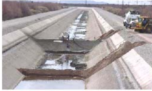
FIGURA 5 .CONSTRUCCIÓN EN MARCHA DE UN VERTEDERO DE CRESTA ANCHA TRAPEZOIDAL EN EL ESTADO DE ARIZONA EEEUU.
