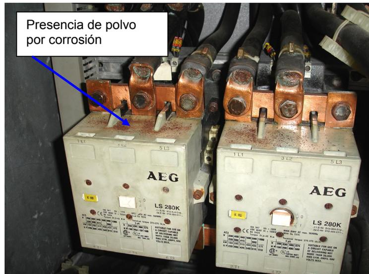
Figura 1.1: Sistema arrancador para un motor
