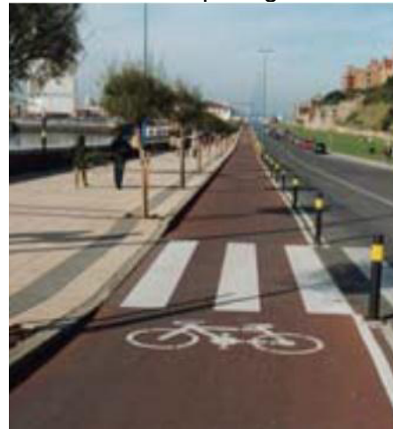
Figura N° 6 Carril bici protegido
