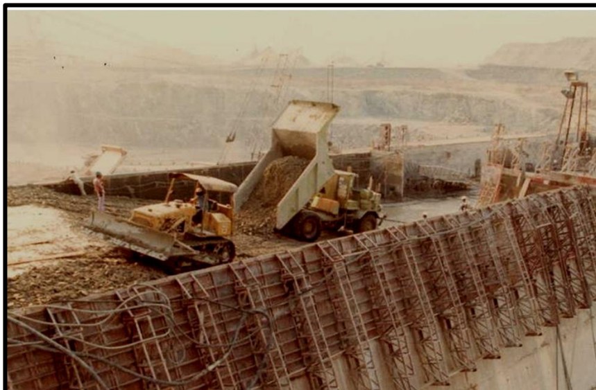
Ilustración 8. 3 Colocación del HCR, Tomado de la Presentación: HCR Evolución y Nuevos Horizontes - Ing. Miguel A. Golik.
