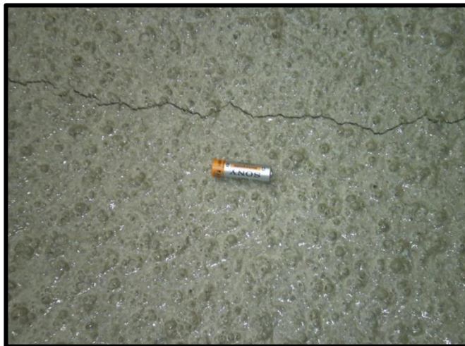
Ilustración 8. 22 Formación de Fisura por Contracción y Secado, Tomado de la Presentación: HCR Evolución y Nuevos Horizontes - Ing. Miguel A. Golik.
