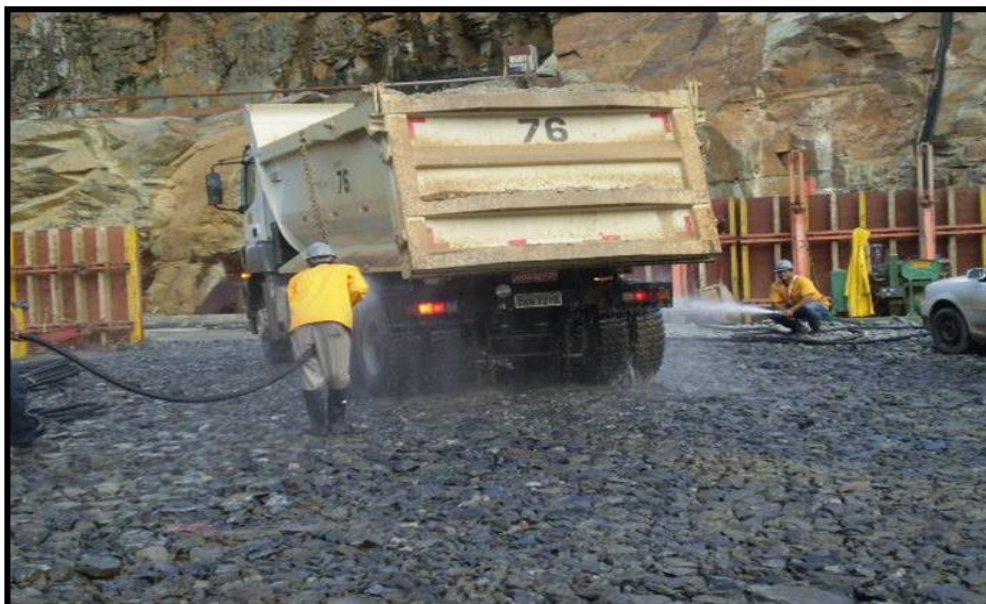
Ilustración 7. 11 Limpieza de Camiones para Evitar Contaminación, Tomado de la Presentación: HCR Evolución y Nuevos Horizontes - Ing. Miguel A. Golik.
