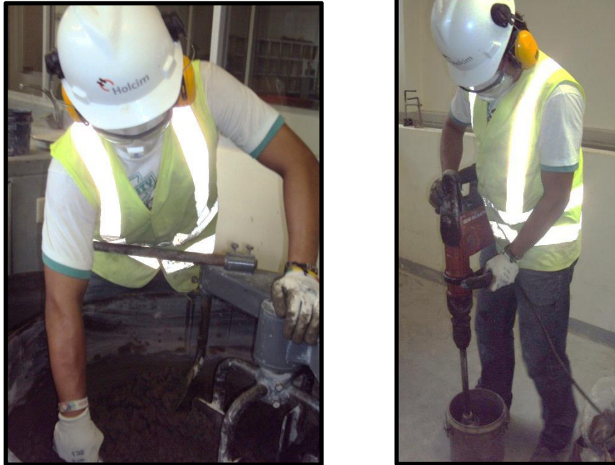
Ilustración 4. 12 Mezclado y Compactación de Materiales.
