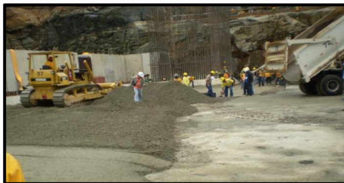
Ilustración 8. 4 Proceso de Colocación y Extensión del HCR, Tomado de la Presentación: HCR Evolución y Nuevos Horizontes - Ing. Miguel A. Golik.
