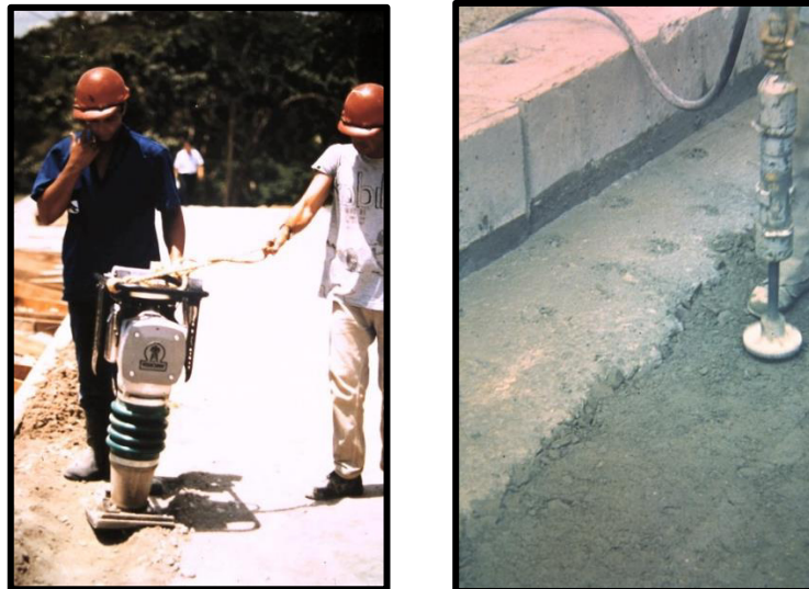
Ilustración 8. 13 Compactación con Equipos Menores, Tomado de la Presentación: HCR Evolución y Nuevos Horizontes - Ing. Miguel A. Golik.
