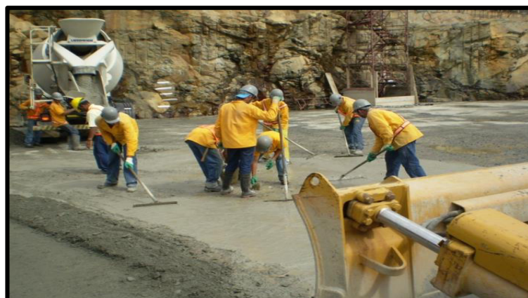
Ilustración 8. 15 Colocación de Mortero de Pega, Tomado de la Presentación: HCR Evolución y Nuevos Horizontes - Ing. Miguel A. Golik.
