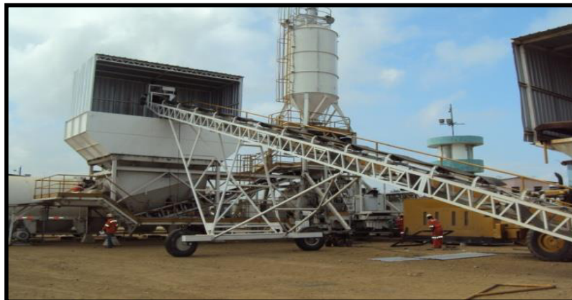
Ilustración 7.4 Almacenaje de Agregados Planta de HOLCIM.
