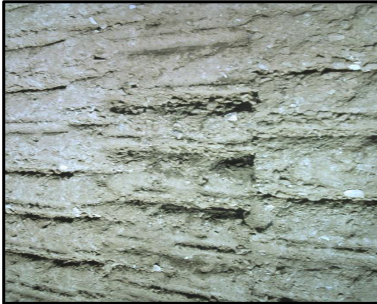
Ilustración 8. 20 Marcas de Equipos sobre Hormigón Endurecido, Tomado de la Presentación: HCR Evolución y Nuevos Horizontes - Ing. Miguel A. Golik.
