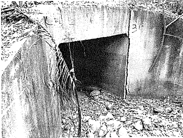
Figura 22 Estructura de entrada de la alcantarilla 2.
