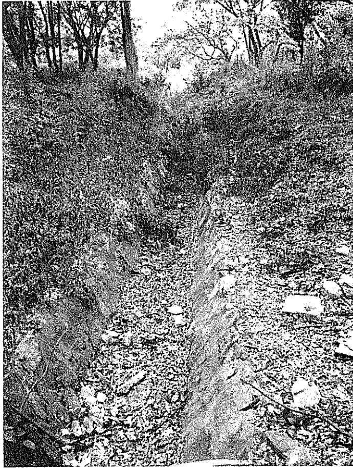
Figura 27 Tramo 3: Canal de sección trapezoidal.
