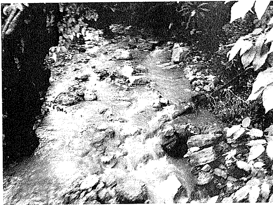
Figura 21 Canal a la entrada de la alcantarilla 2
