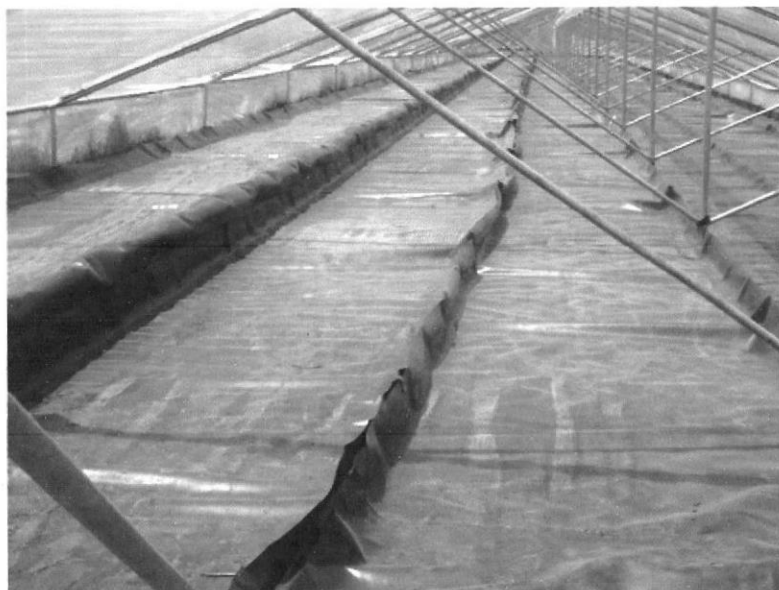
Figura 15: Estructura del canal.
