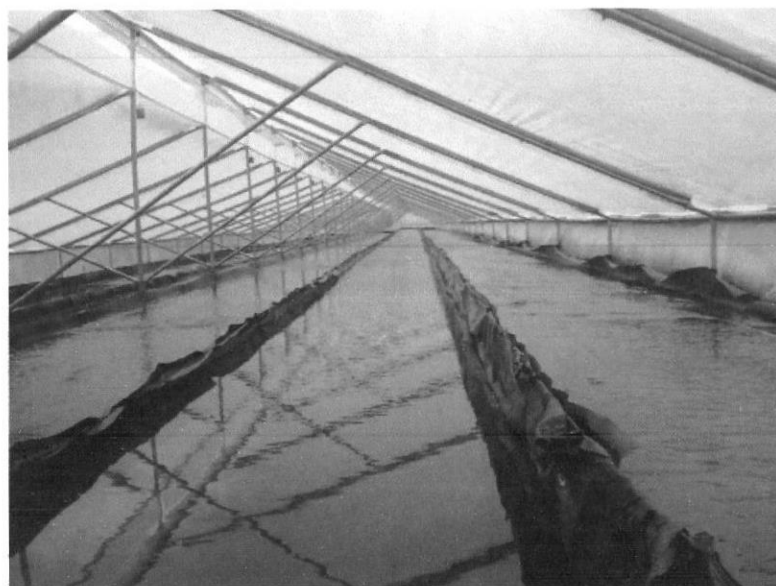
Figura 18: FBR en plena operación.
