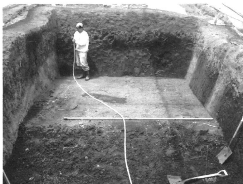
Figura 16: Construcción del tanque.
