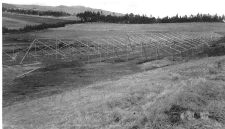
Figura 14: Construcción de la estructura de los invernaderos.
