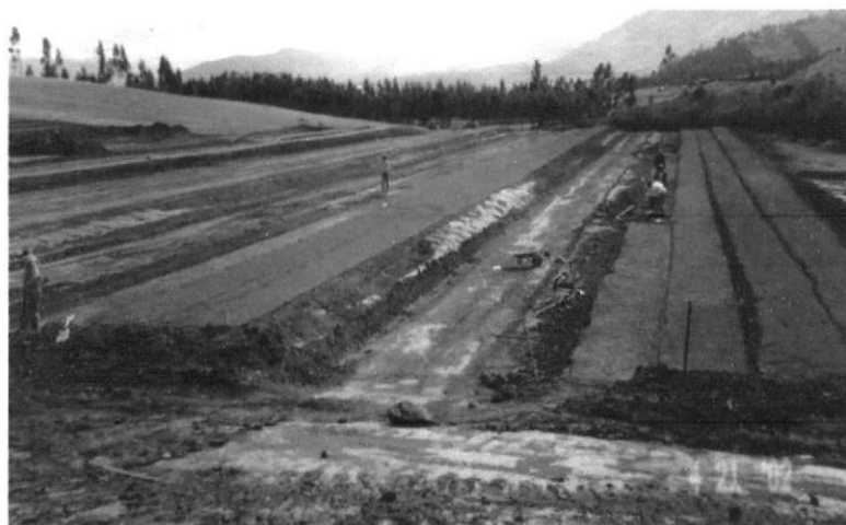
Figura 13: Vista de las rampas conformadas en el terreno.
