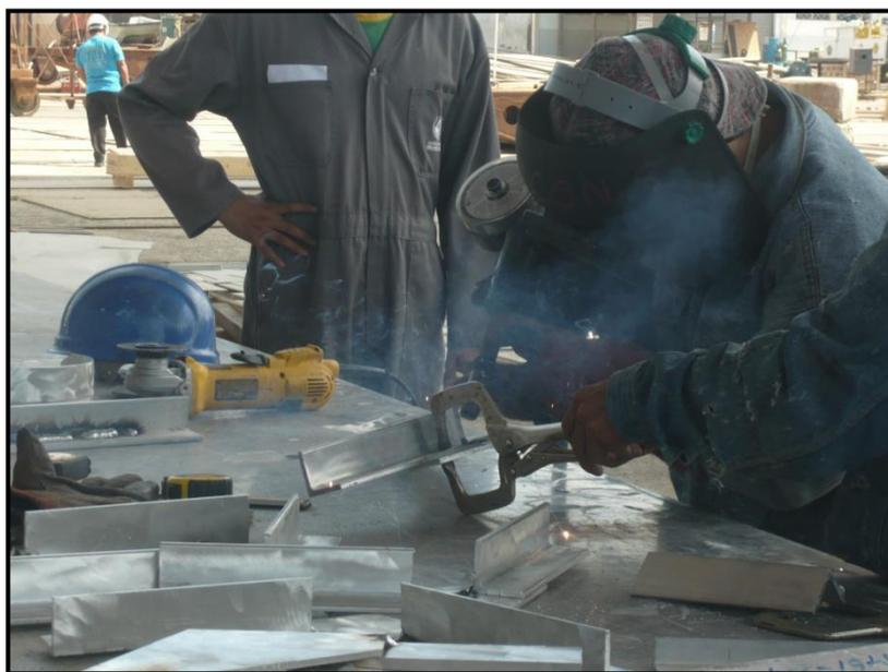
Figura No. 25 Soldadura de cada conexión estructural
